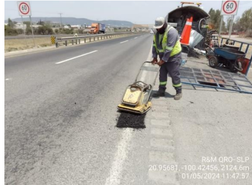
Figura 4. Trabajos de baches en frio.
