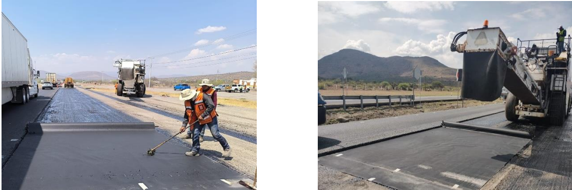
Figura 6. Colocación de Geomalla
