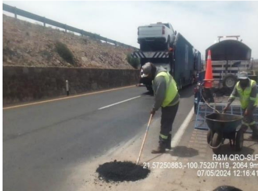
Figura 4. Trabajos de baches en frio.
