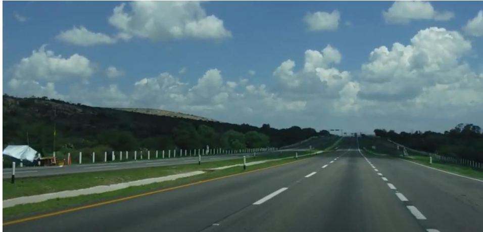
Figura 7. Estado actual carretera Querétaro - San Luis Potosí.
