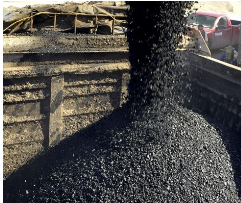
Figura 1. Mezcla asfáltica vertida en camión Volteo
