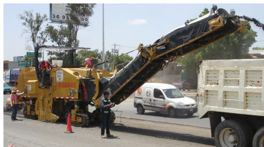
Figura 2. Obtención de RAP en carretera
