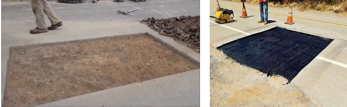
Figura 10. Limpieza y aplicación de riego de liga
