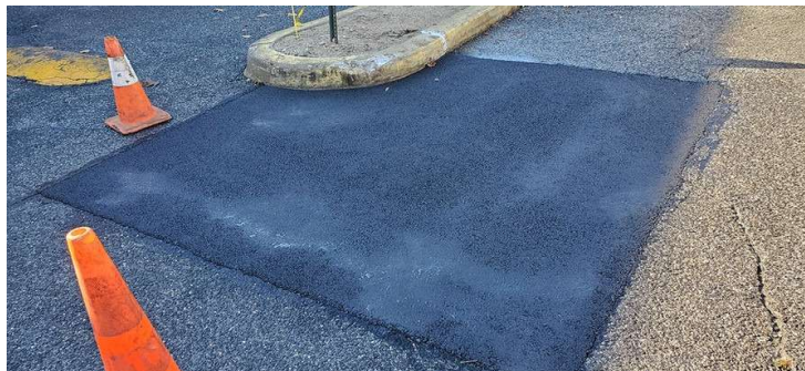
Figura 12. Textura después del bacheo
