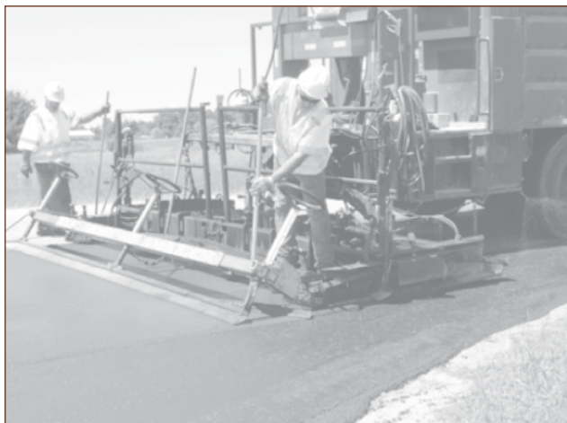
Figura 4. Colocación de micro-superficies.
