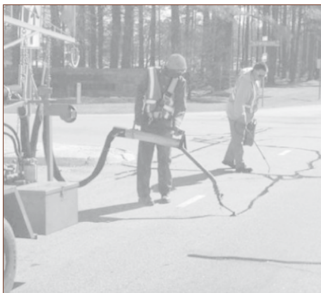
Figura 5. Sellos de grietas.
