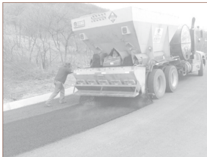
Figura 3. Colocación del riego de sello.
