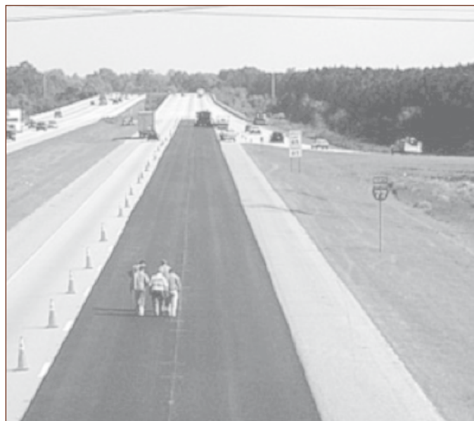
Figura 2. Mezcla de capa delgada para cubrir el sangrado como tratamiento superficial.
