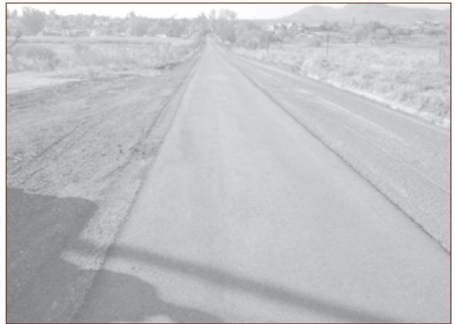
Compactación de carpeta y tramo recién compactado.
