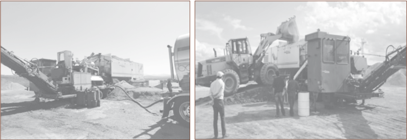
Figura 3. Planta mezcladora utilizada para la elaboración de la carpeta de mezcla en frío.
