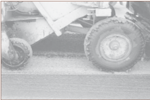
Figura 2. Diferente comportamiento de emulsiones de adherencia.
