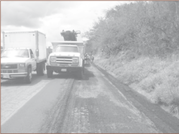
Figura 6. Tramo recuperado de mezcla en frío (km 93+700 al 92+726 carril derecho).
