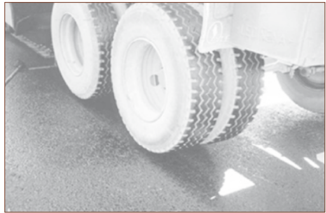
Figura 2. Diferente comportamiento de emulsiones de adherencia.
