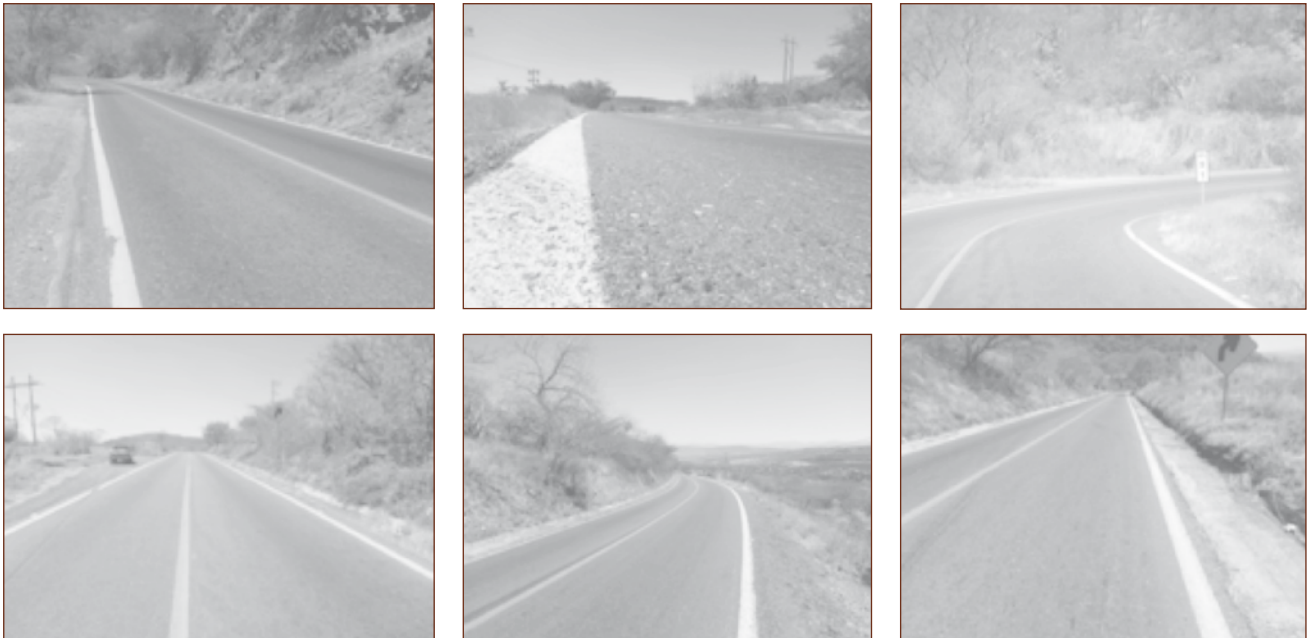
Figura 9. Vista del tramo carretero en febrero de 2016.
