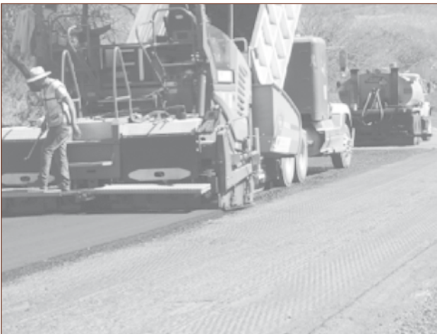
Figura 4. Tendido y compactación de la mezcla de prueba.
