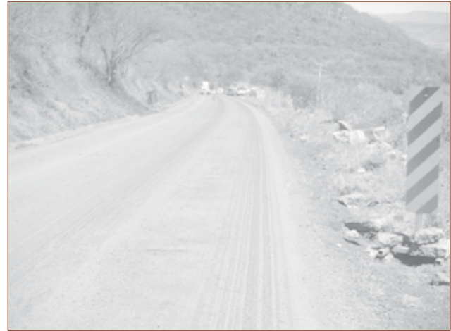
Figura 6. Tramo recuperado de mezcla en frío (km 93+700 al 92+726 carril derecho).
