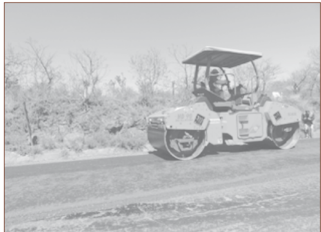
Figura 4. Tendido y compactación de la mezcla de prueba.
