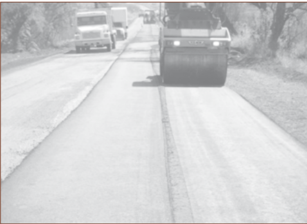
Compactación de carpeta y tramo recién compactado.
