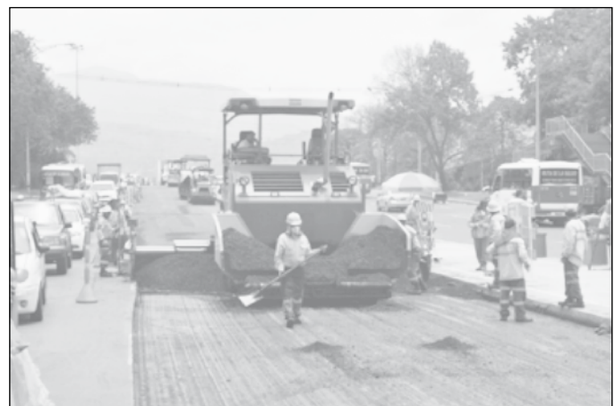
Figura 1. Actividades de conservación en un pavimento flexible (renovación y sobrecarpetas).
