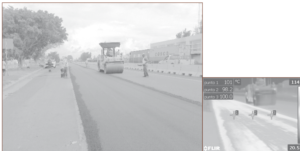
Figura 3. Temperatura mínima de compactación de 95 °C de la mezcla asfáltica tibia para este tratamiento.
