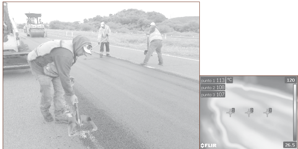
Figura 1. Aplicación del tratamiento superficial en la autopista Guadalajara-Colima, se observa que la mezcla asfáltica tibia se puede manipular por los trabajadores hasta temperaturas de 110 °C.
