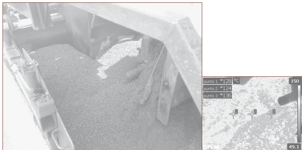
Figura 2. Temperaturas de mezclado de la mezcla asfáltica tibia para este tratamiento en la máquina extendedora.
