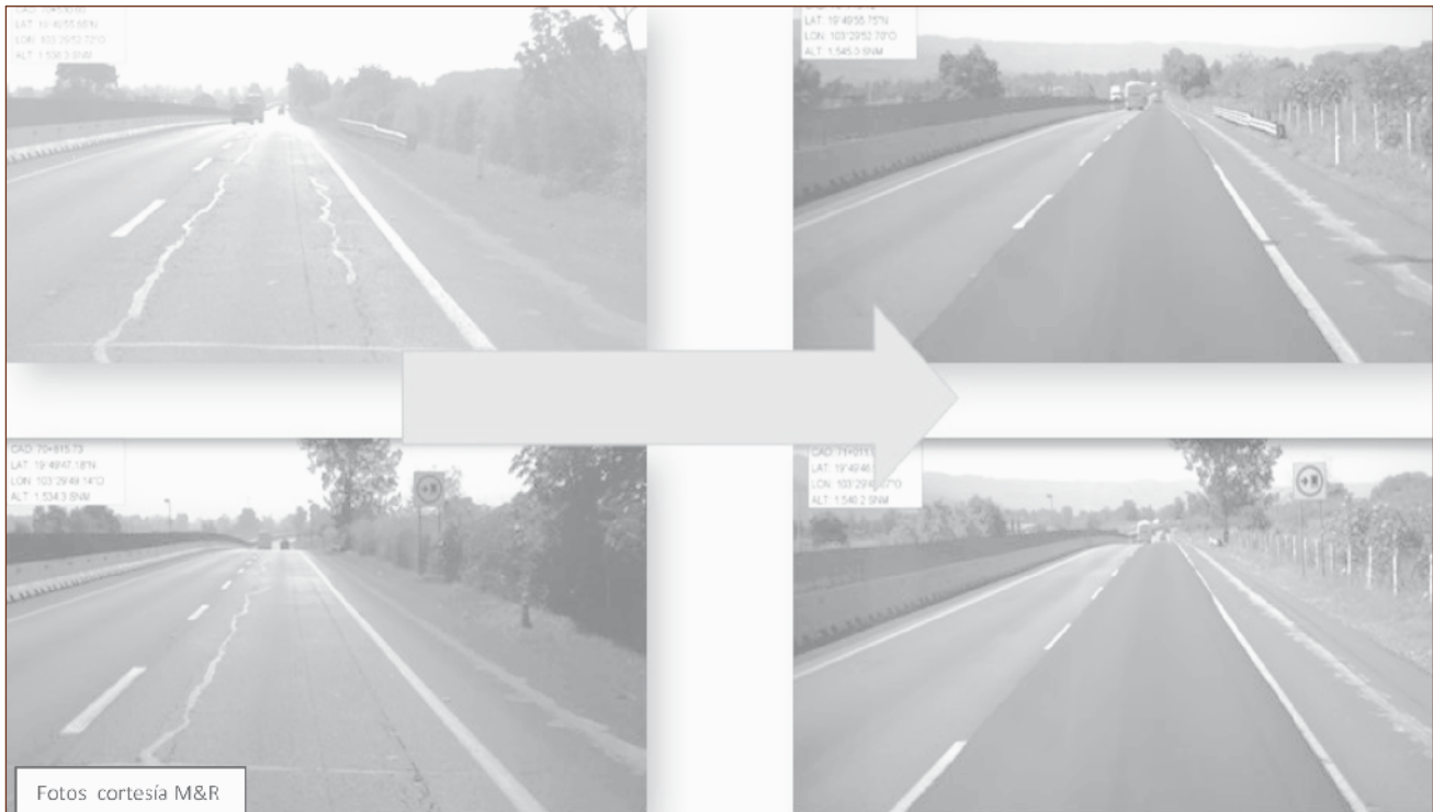
Figura 7. Apariencia del tramo carretero en la autopista Guadalajara-Colima del kilómetro 69.980 al 71.060 antes y después de haber sido aplicado el tratamiento superficial propuesto en este estudio.
