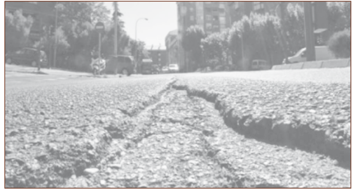
Figura 6. Carpeta asfáltica degradada derivada de un mal mantenimiento y agentes externos.
