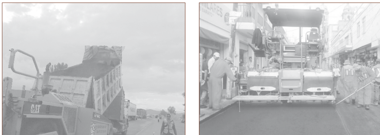
Figura 4. La mezcla asfáltica para este tratamiento puede ser aplicada con cualquier tipo de finisher.
