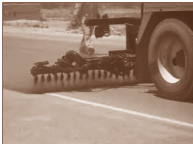
Figura 1. Aplicación de riego con emulsión asfáltica.
