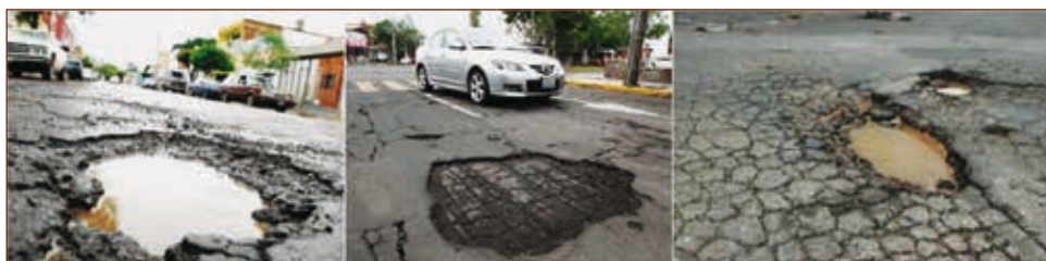
Figura 1. Daño por humedad en vías mexicanas.
