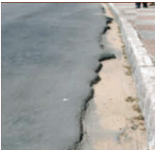
b) Deslizamiento de la mezcla asfáltica.
