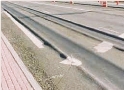
a) Fundamento plástico de Wheel tracking.
