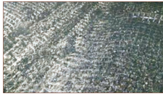
Daños observados en la malla con revestimiento BITUMINOSO.
