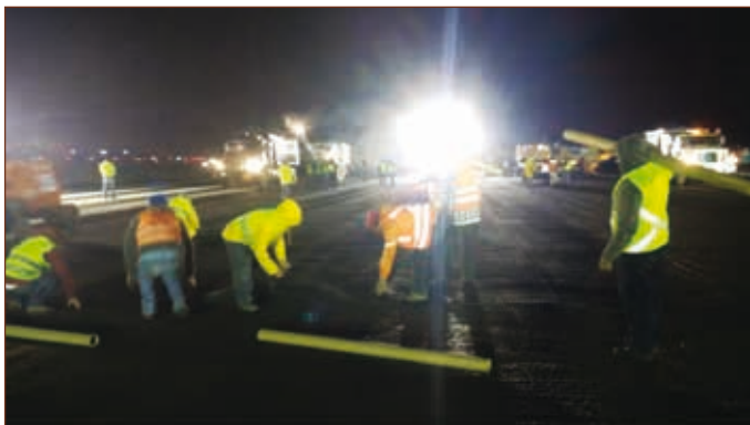
Colocación de la Geomalla de Fibra de Vidrio con revestimiento BITUMINOSO.
