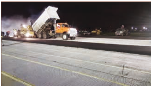
Fotos de la instalación en AICM de GGBASIC100.
